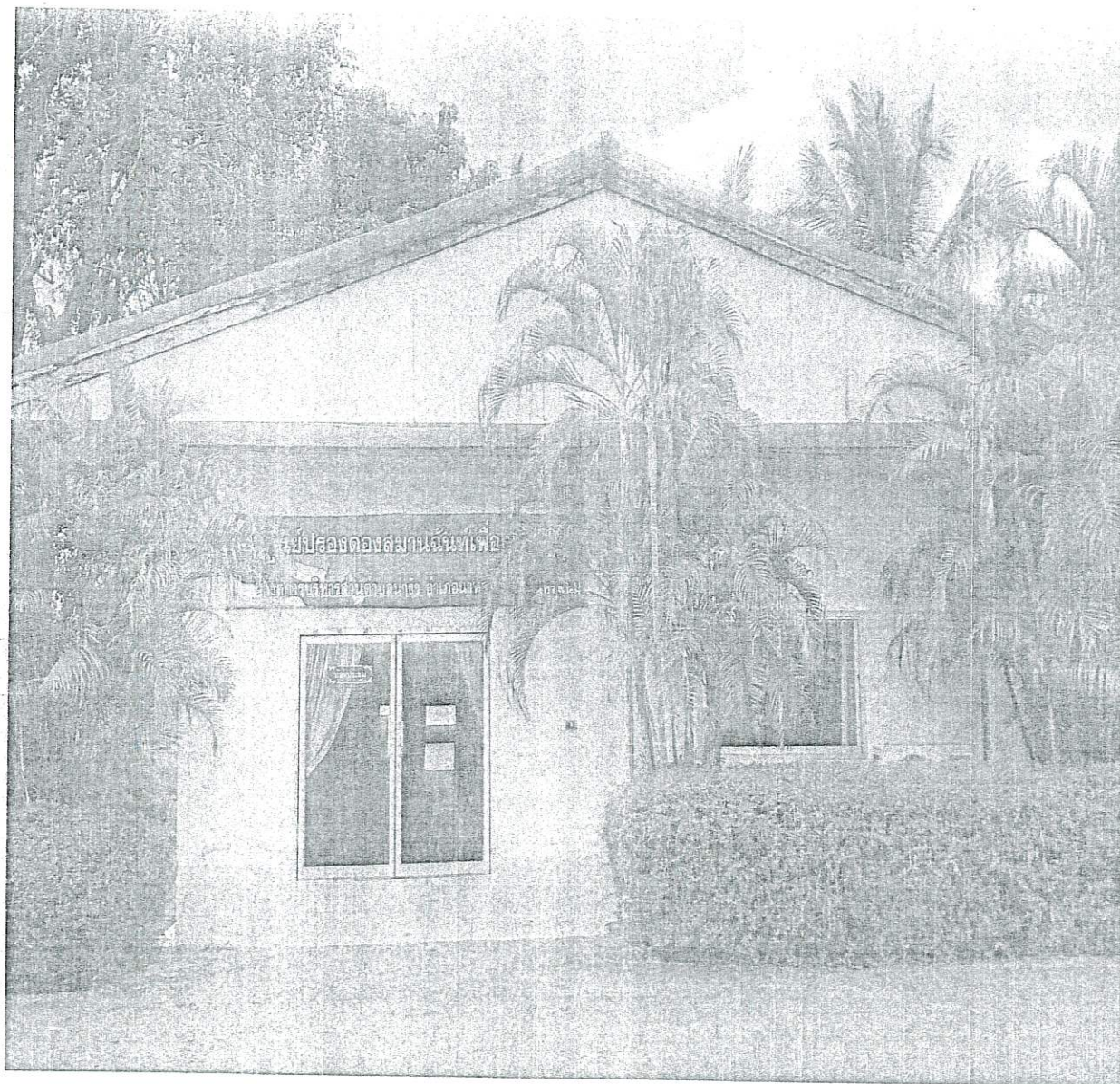
สภาพปัจจุบันของที่ตั้งโครงการก่อสร้างอาคารอเนกประสงค์
