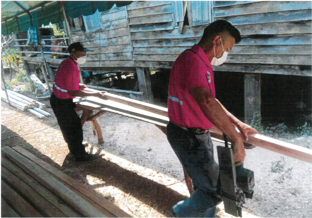
ภาพถ่ายก่อนการทํำบ้านนางสาวถนอม บุณนท
