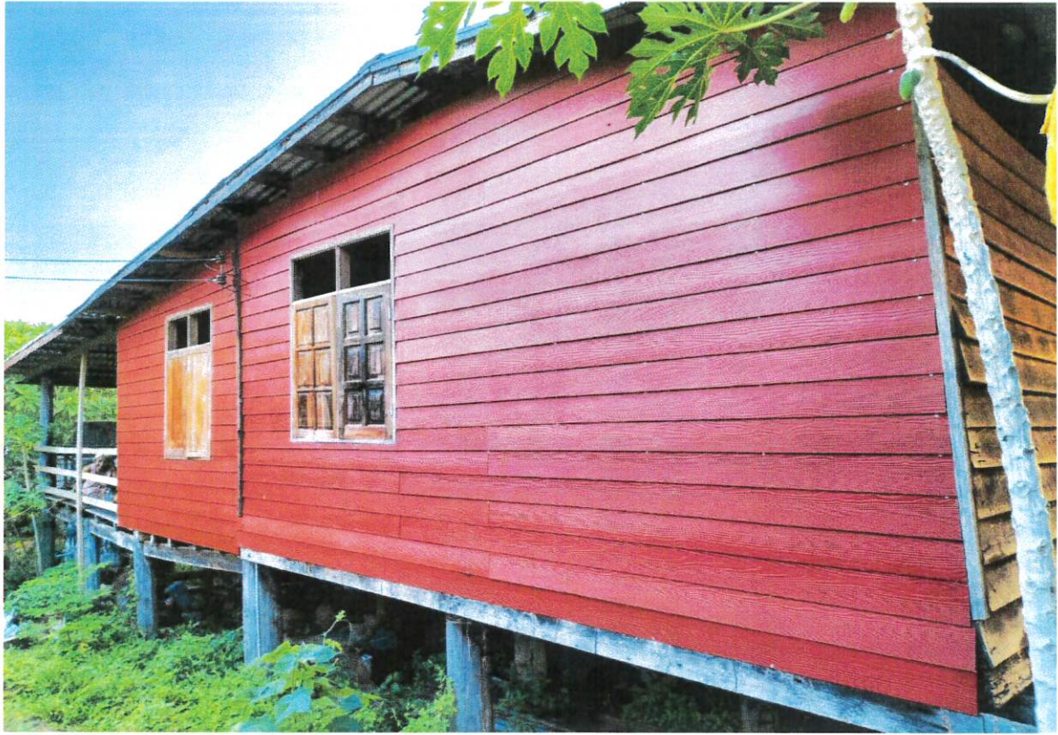
ภาพถ่ายหลังดำเนินการเสร็จบ้านนางสาวถนอม บุนนที
