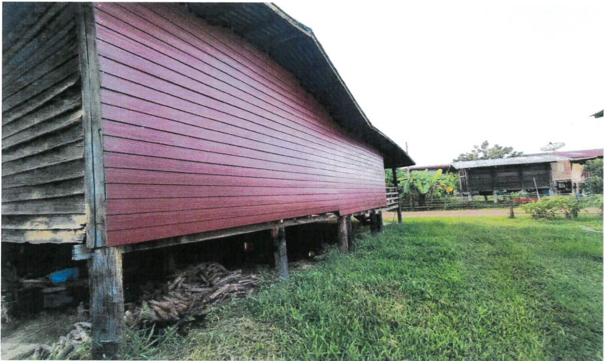
ภาพถ่ายหลังดำเนินการเสร็จบ้านนางสาวสนิท เป้าคำ
